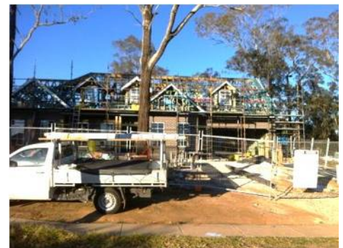
近所の建設中の家
